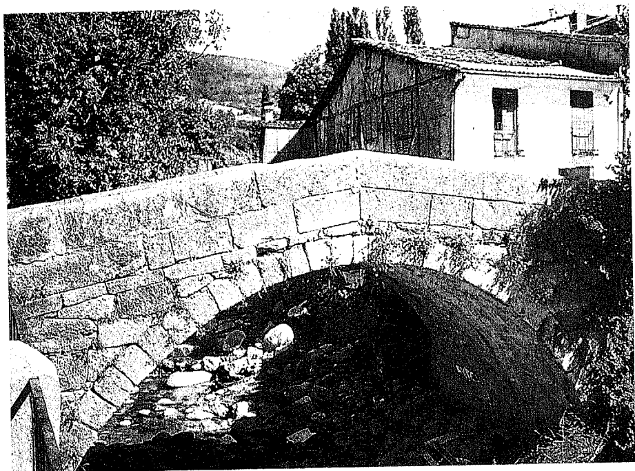
Puente sobre el río Jerte a su paso por Tornavacas (1545).
